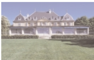
Le restaurant du Parc des Eaux-Vives bientôt rouvert
